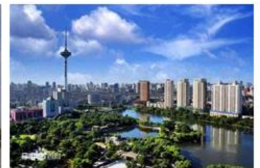
遼寧廣播電視塔
